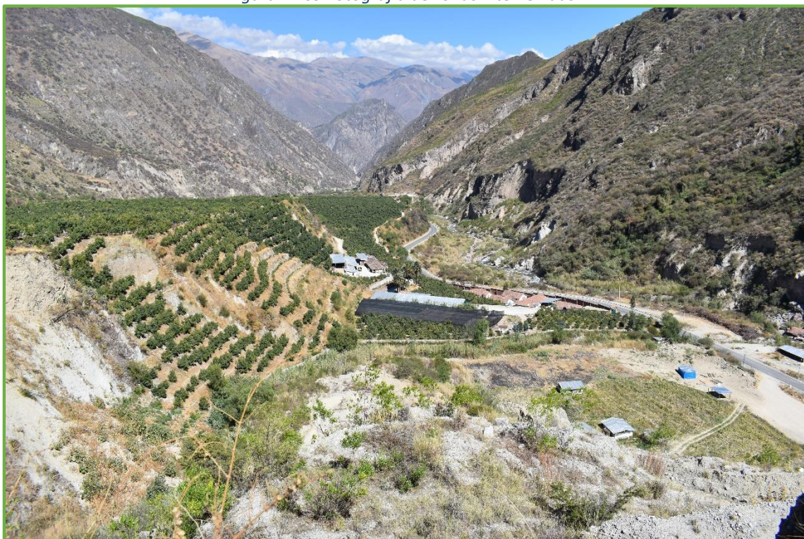
Figura N° 69 Fotografía de zonas intervenidas
