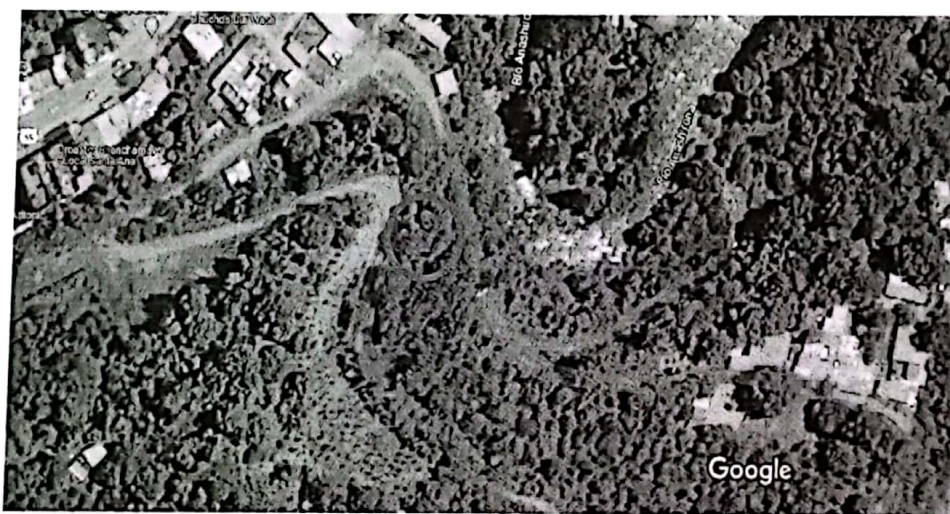
Figura 1. Zona Afectada por arroyo de arroyo de desmonte, piedras, rocas y otros (Rio Anashirona – Alto Vista Alegre)
