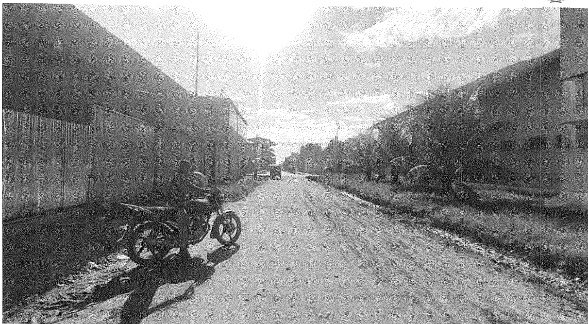
IMAGEN 03: Vista del Jr. Buenos Aires, se tiene conocimiento que no cuentan con veredas ni cunetas, en temporadas de lluvia suele inundarse
