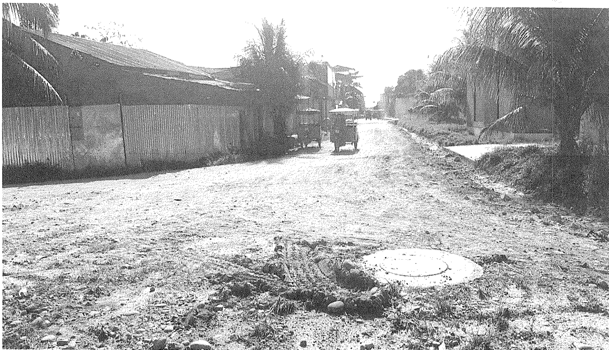
IMAGEN 07: Como se observa la calle no está pavimentada y el buzón está expuesto a daños
