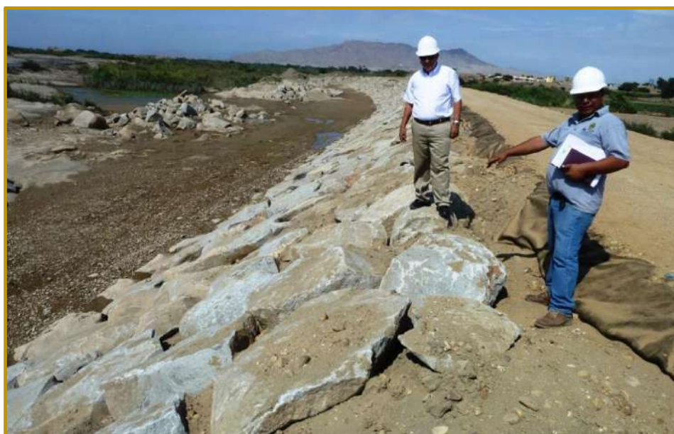
Imagen 1. Protección – Dique enrocado acomodado
