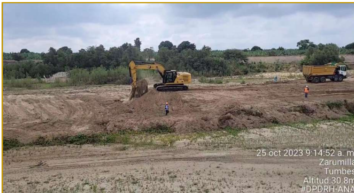
Imagen 6. Extracción de material sedimentado en el cauce
